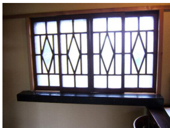
色ガラスの入った建具を移設
