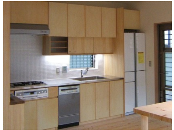
キッチンの上下の木製のキャビネットは、大工さん製作で作り付け
