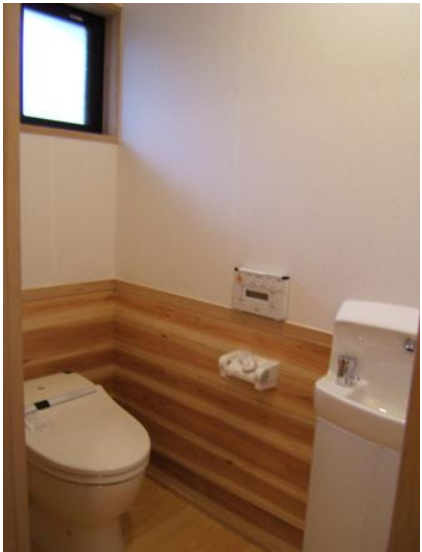
腰壁は、杉板張り
