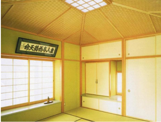
舟底天井にし広くゆったり感を演出した和室
