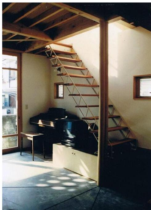
床はコンクリート 階段は鉄筋
