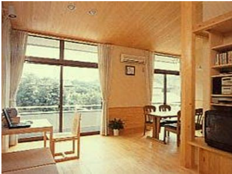
右側の柱はヒノキ材の大黒柱で、八角形に大工さんと家族の皆で削りだしました。 年々色艶が変化し愛着がわきます。
