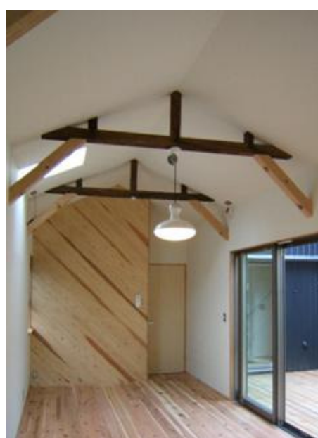
梁を化粧に出した船底天井
