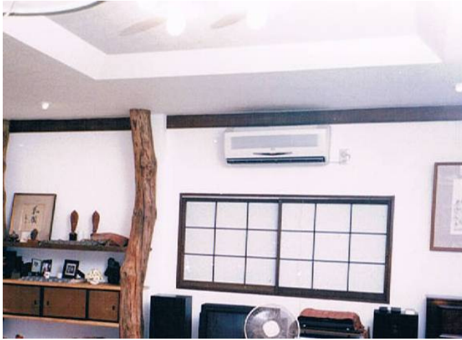
一部 折り上げ天井
