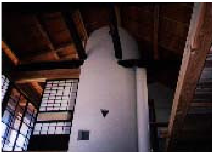
2階分そっくり吹き抜け
