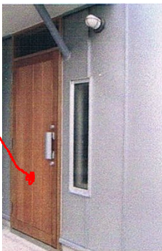
玄関ドアの建具とドア枠は木（米杉）で作る
